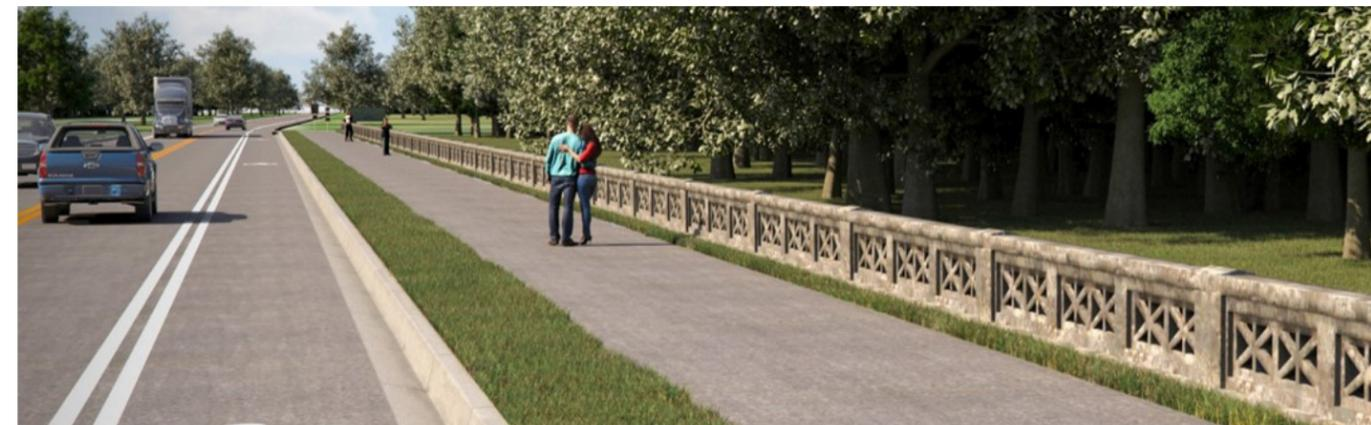
Está previsto que la barandilla del puente existente se reutilice. El proyecto evaluará las alternativas de barandilla de puente según el nuevo puente para imitar el patrón de las barandillas actuales manteniendo al mismo tiempo las normas de seguridad.
