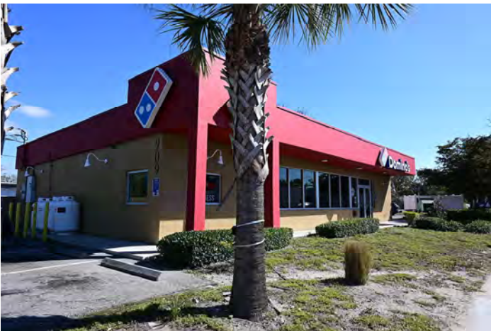
8MA03132_e Facing SE
