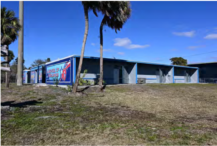
8MA03136_c Facing NE
